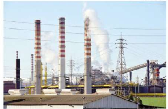
L'impianto a Taranto. Per i sindacati nodo decarbonizzazione centrale
